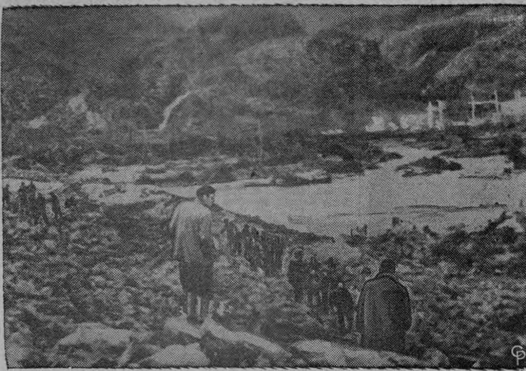
Trabajadores de salvamento recuperan cadáveres de algunas de las 200 personas que fueron arrastradas a la muerte en la aldea de Ribadellago, España, al romperse una represa hidroeléctrica de 22 metros de altura. Una catarata de 30 metros de altura se precipitó sobre la aldea. Una tercera parte de la población pereció.
